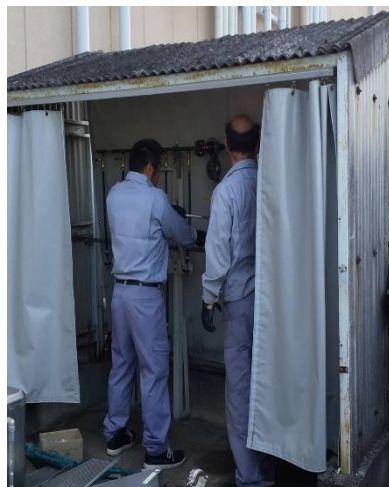
ガス管の工事
