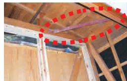
水平構面の隅角部に設置する火打金物は強度確保だけでなく、梁や母屋の落下を防ぎます。
