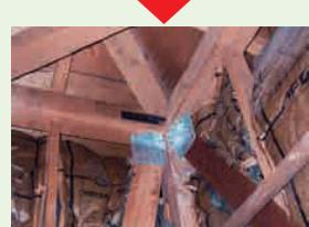
既存の筋かい端部を金物で補強
